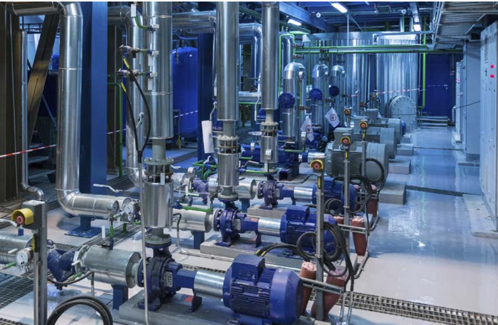
Pumpenanwendung, z. B. Energieeinsparung, in der Gebäudeautomation mit Frequenzumrichtern
