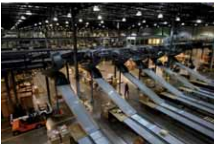
Komplexe Förderanlagen bieten viel Einsparpotential an Energie
