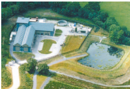
Beispiel für eine schwer erreichbare Pumpstation.
